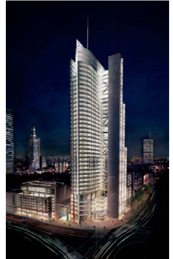
Der 194 m hohe Gebäudekomplex Rondo 1 in Warschau, führt Beleuchtungs- und Notbeleuchtungsanlage zusammen.
